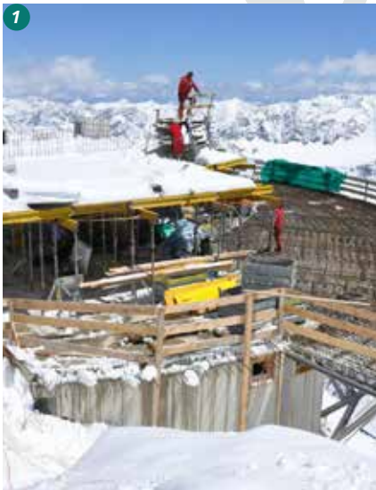
CONSTRUCTION OF TOP STATION / AUSTRIA CONSTRUCTION D'UNE STATION DE MONTAGNE / AUTRICHE Safe work at the highest building in the Eastern Alps / 3440m Travail en toute sécurité sur le bâtiment le plus haut des Alpes orientales / 3440m
