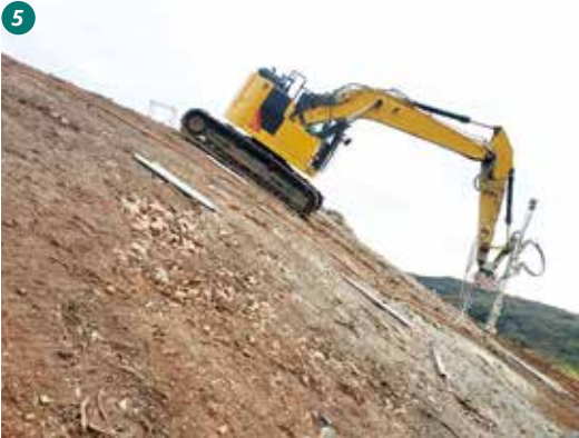
ENERGIEWIRTSCHAFT / KALIFORNIEN INDUSTRIA ENERGETICA / CALIFORNIA Ankerungen eines Solarparks unter steilsten Bedingungen Ancoraggio di un parco solare nelle condizioni più ripide
