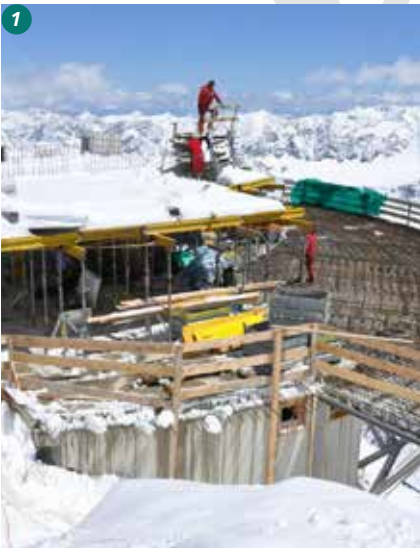
ERRICHTUNG BERGSTATION / ÖSTERREICH COSTRUZIONE DI UNA STAZIONE ALPINA / AUSTRIA Sicheres Arbeiten am höchsten Gebäude der Ostalpen / 3440m Lavoro sicuro presso il più alto edificio delle Alpi orientali / 3440 m
